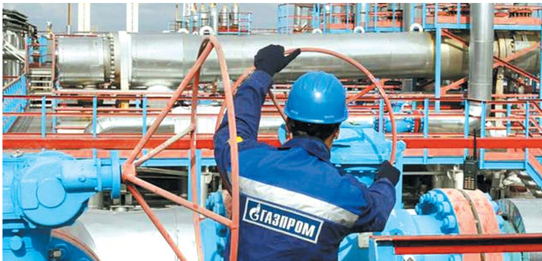
俄罗斯天然气工业股份公司的员工在进行管道作业。(资料片)
