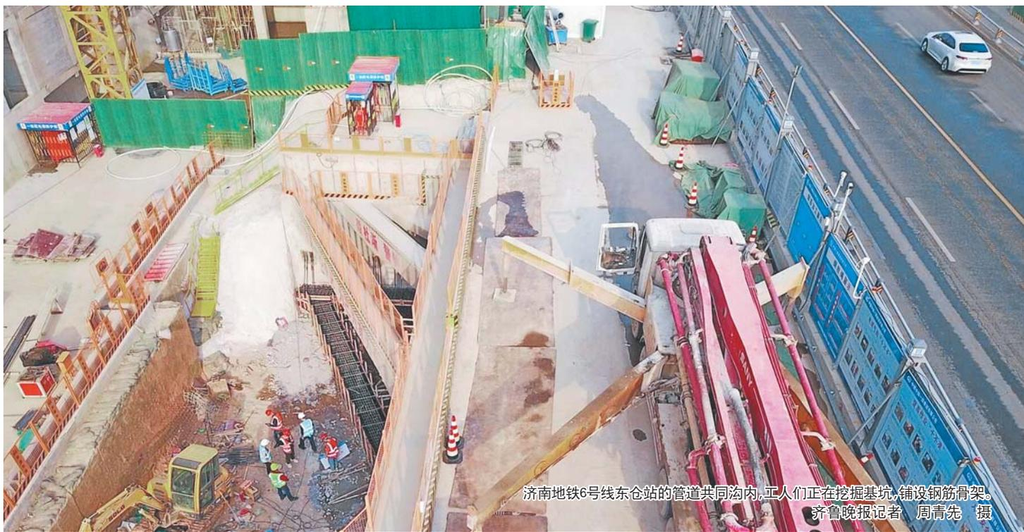
济南地铁6号线东仓站的管道共同沟内,工人们正在挖掘基坑,铺设钢筋骨架。
