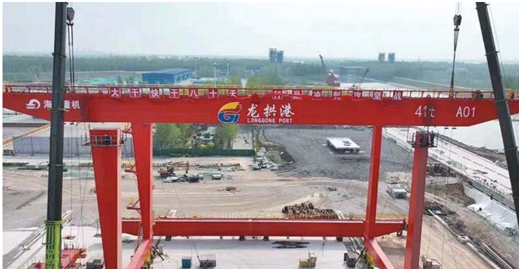
如火如荼建设中的龙拱港。
