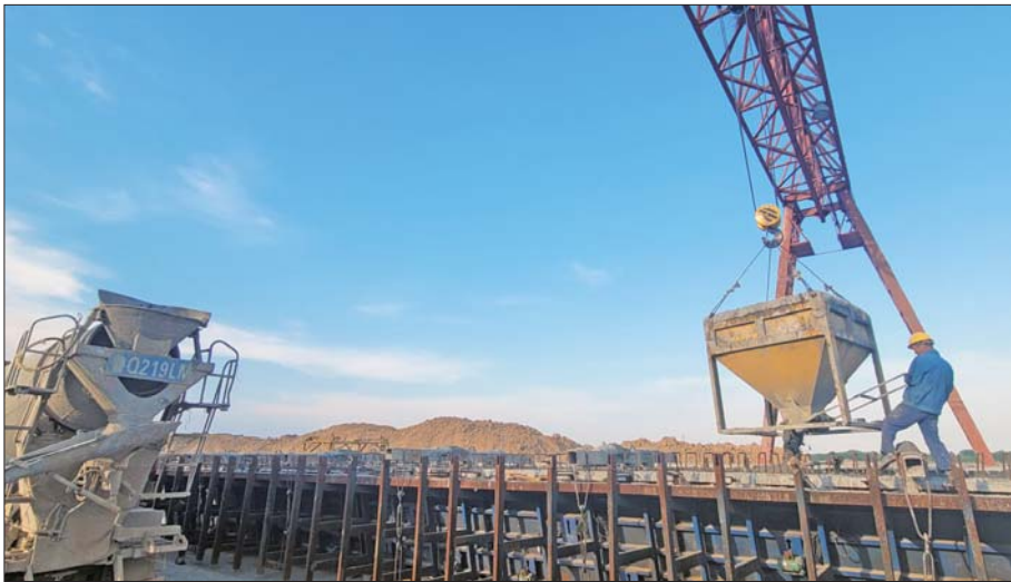
建设人员正在进行悬浇梁桥正常节段浇筑工作。
