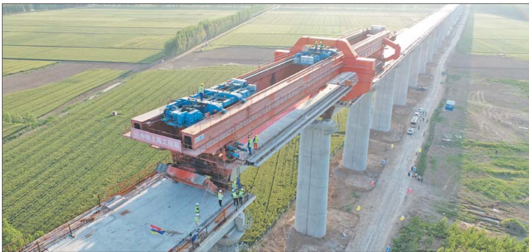
济郑高铁在如火如荼建设中。通讯员 熊岭 陈一帆 摄
