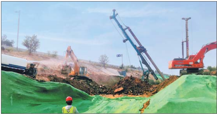
仲官桥正在进行桩基施工。
