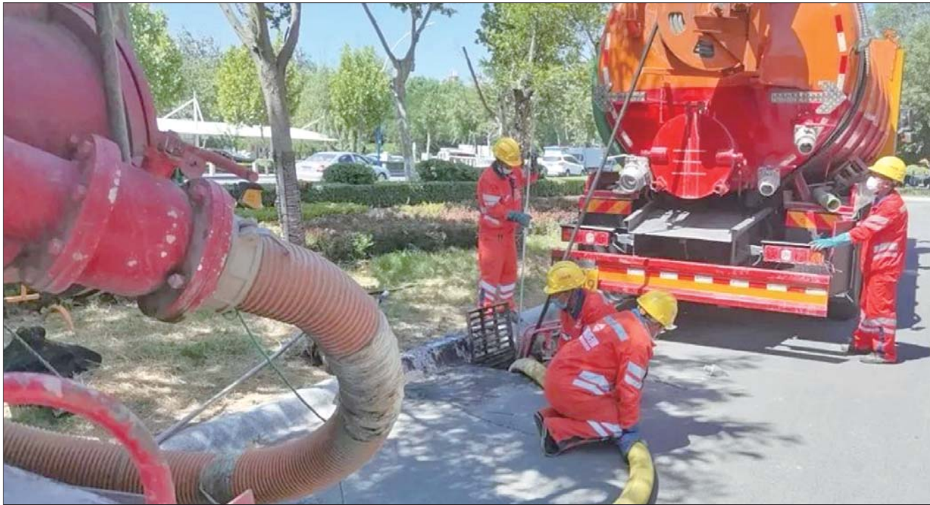
对全区的雨水管网清淤疏通。
