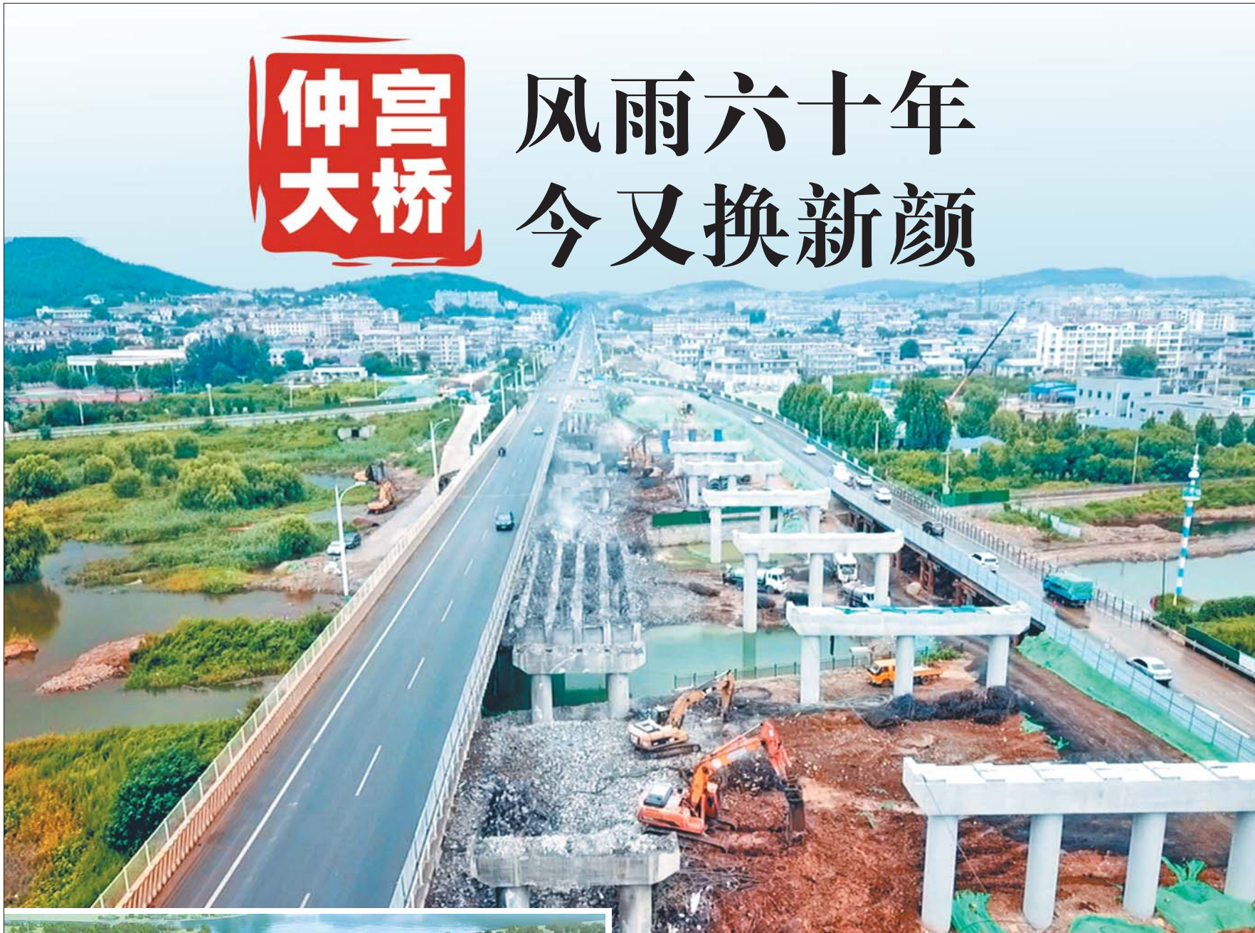
▲济南仲宫大桥老桥东半幅正在拆除,西半幅将保留。视频截图 ◀仲宫大桥老桥将改造为观景平台及互通立交(效果图)。
