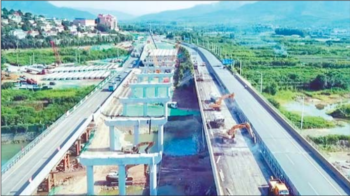
仲宫大桥老桥拆除，新桥正在进行梁板吊装。
