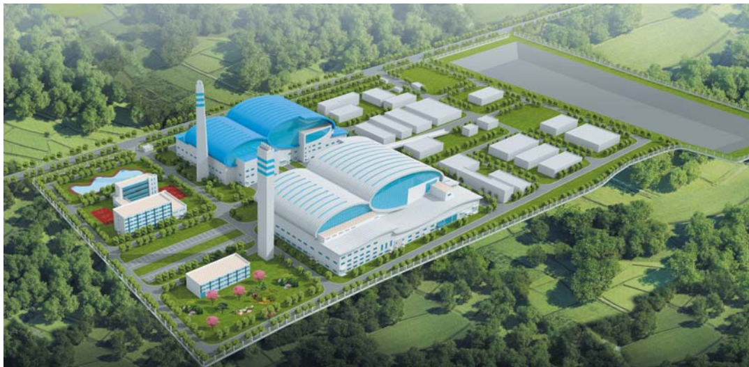
生活垃圾焚烧发电项目二期工程已完成工程量的60%。
