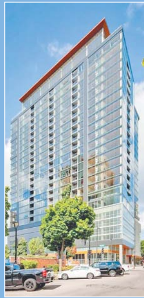
目前世界最高重型木结构建筑Ascent。
