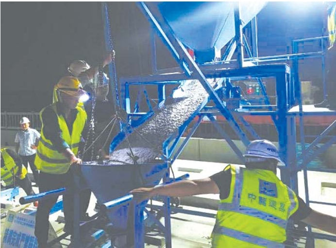
CRTSⅢ型轨道板，项目团队在全线率先进入无砟轨道施工，打破
