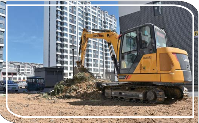
文博家园小区正在进行绿化带升级改造。
