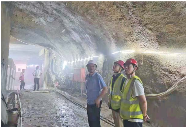
2021年,张学家(左一)在青岛地铁4号线隧道内检查施工质量。
