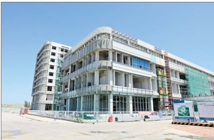
建设中的县妇幼保健院项目。
