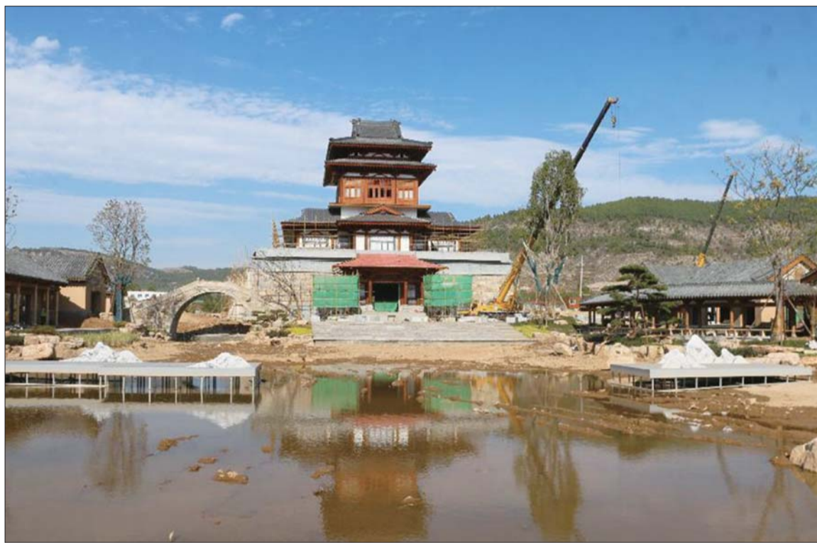
正在紧张施工的鲁源小镇“尚礼阁”建筑群。
