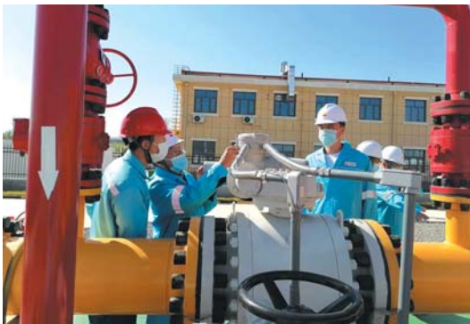
进行燃气检查。
