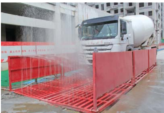
监督建筑工地降尘处理。
