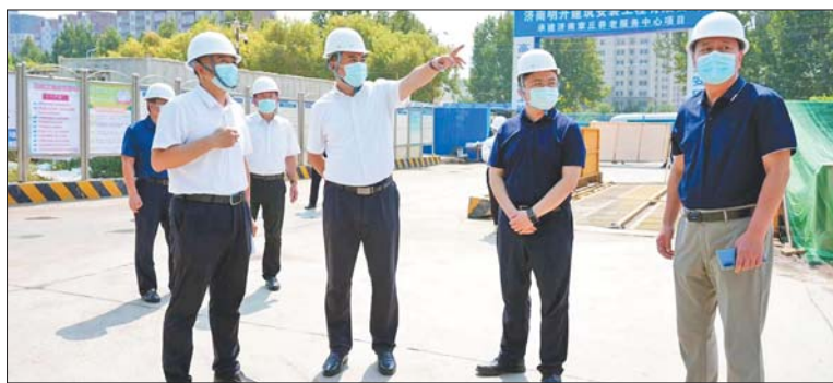
区委书记马志勇视察养老服务中心建设项目。
