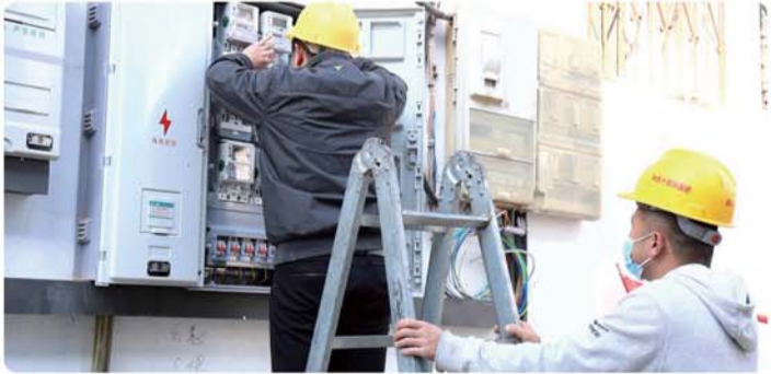
施工人员在为老旧小区更换电表。
