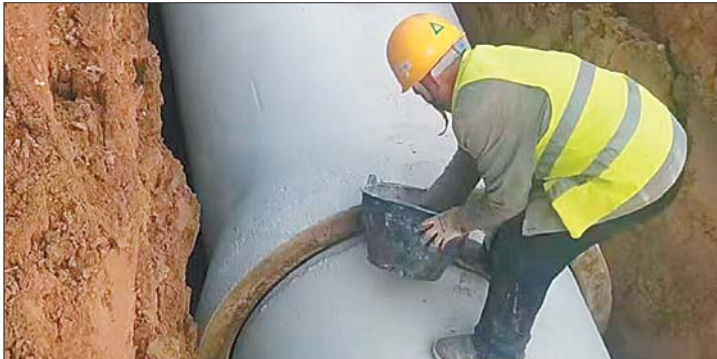
四镇DN800污水管道施工。
