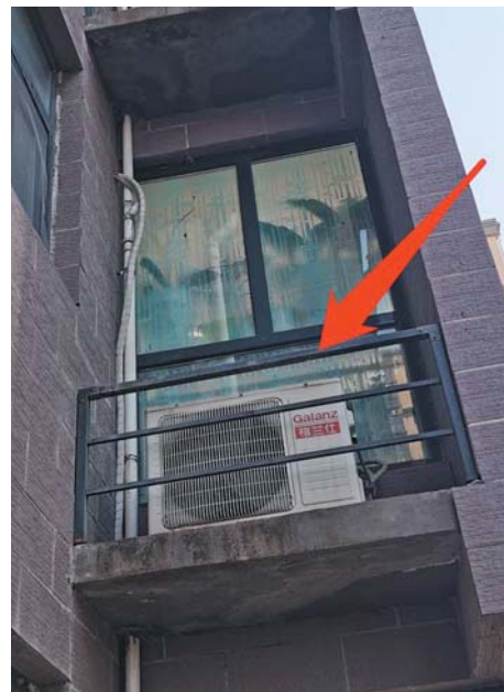
当时小女孩就困在二楼窗外空调外机上。
