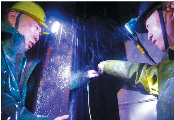
井筒淋水段，两名工人合力更换罐道梁上的螺母。
