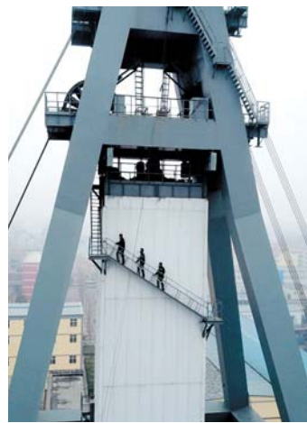
工人们每天都要爬上62米高的井架检查天轮运转情况。
