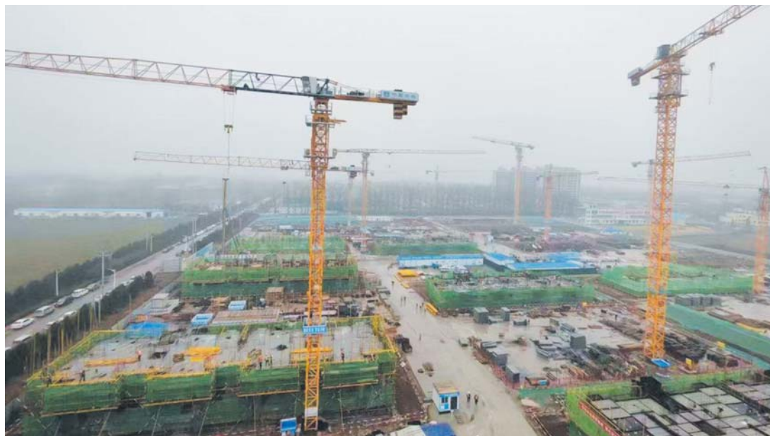
争分夺秒抢工期、赶进度，努力将“施工图”变成“实景图”。
