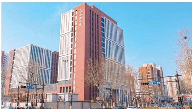
中国铁塔北方数据中心项目
