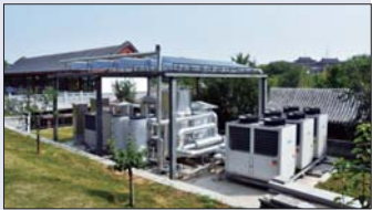
力诺瑞特联合上海交通大学首创的太阳能+高温热泵蒸汽系统。
