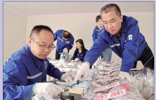
供水分公司滨河销售营业部工作人员帮助企业对水表房管线运行、水表顺时流速进行检查。
