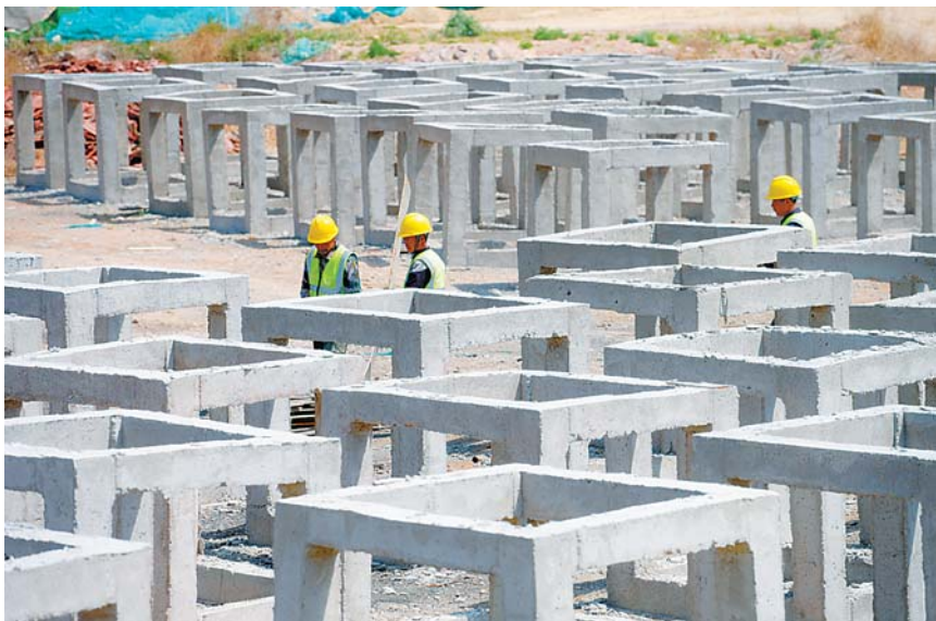
人工藻礁是为了改善藻类生长环境、增殖保护渔业资源设置的水下构造物。记者 赵金阳 摄
