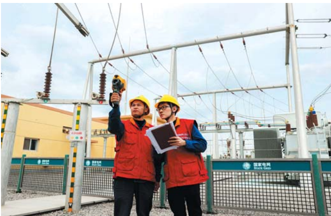
供电员工对辖区变电站设备开展巡视测温，确保五一供电稳定。徐娜 摄
