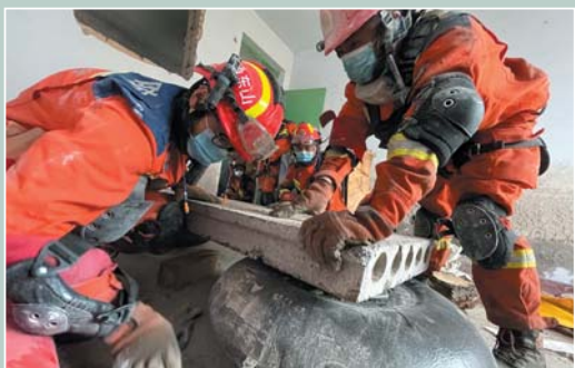
▲救援人员借助专业设备对坍塌楼板进行顶升、支撑,并清理下方障碍物,打通“生命通道”。
