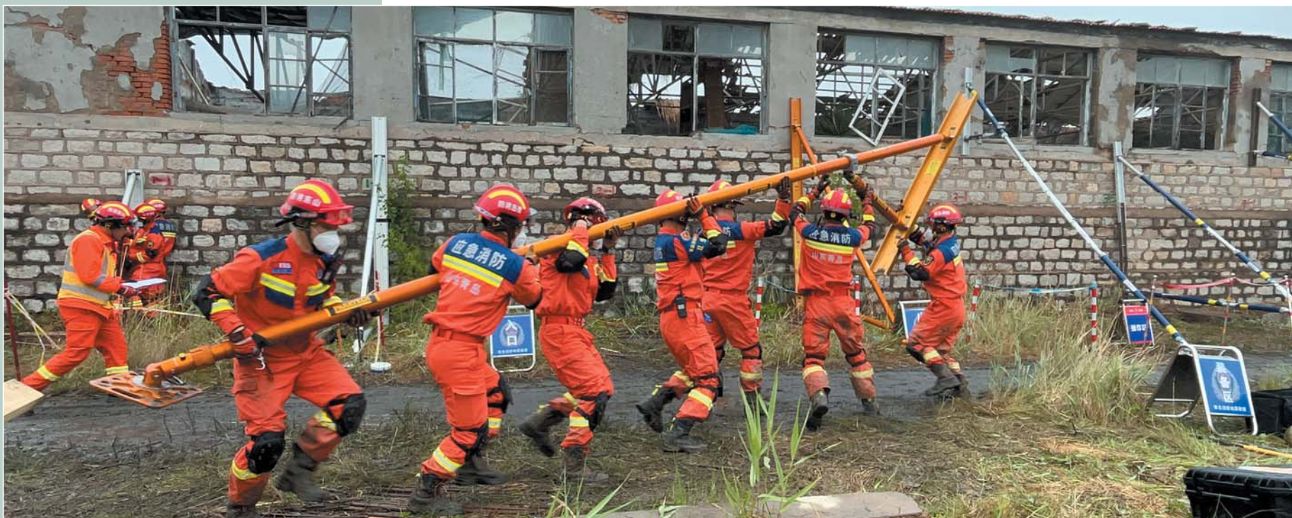
▲救援人员对受损建筑进行固定支撑,保证自身及被困人员安全。
