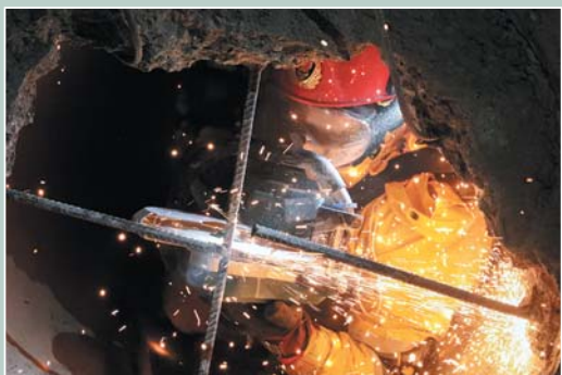
▲救援人员破拆封堵救援通道的水泥管道。
