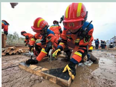
▲救援人员制作、加工各种木制支撑(构件),以便稳定被撑物的结构,确保进入废墟作业人员及被困伤员的生命安全。
