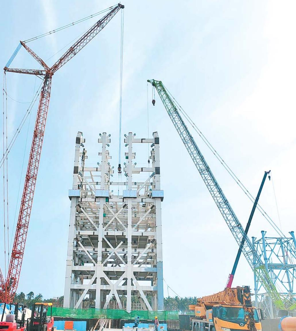
把一件件钢结构模块像搭积木一样,搭成二三十层楼高的发射架,外立面严丝合缝,垂直度偏差不超过3毫米。近日,中国首个商业航天发射中心发射架迎来封顶,鲜有人知道,它的钢结构模块是由一家名为山东经典重工的民营企业提供的,2022年北京冬奥会开幕式上,也是这家企业参与装配的“冰瀑”一度惊艳全场。
