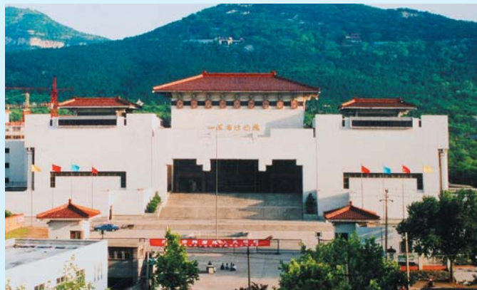
原山东省博物馆千佛山馆陈列楼
