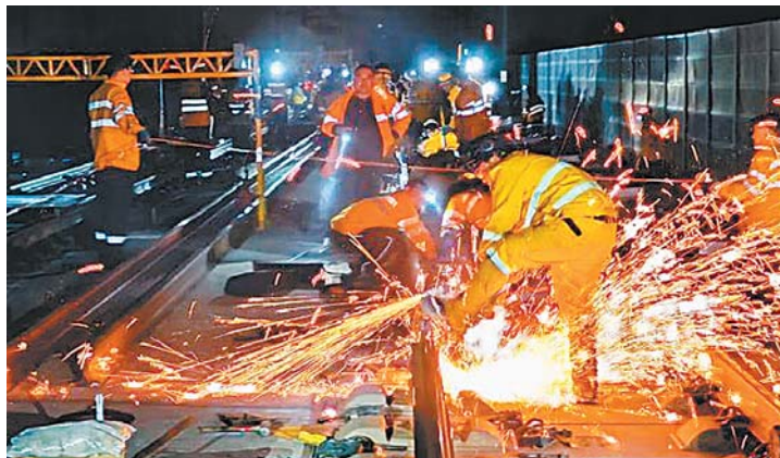
京沪高铁山东段道岔换轨施工现场。
