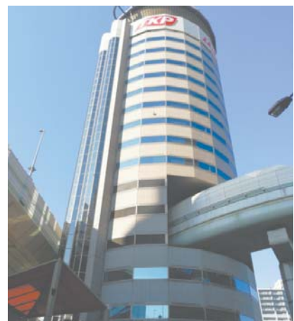
国外轨道交通穿越城市楼宇。
