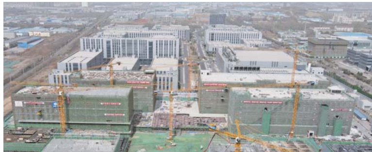
中国十九冶山东公司承建的淄博电子信息科创园项目。
