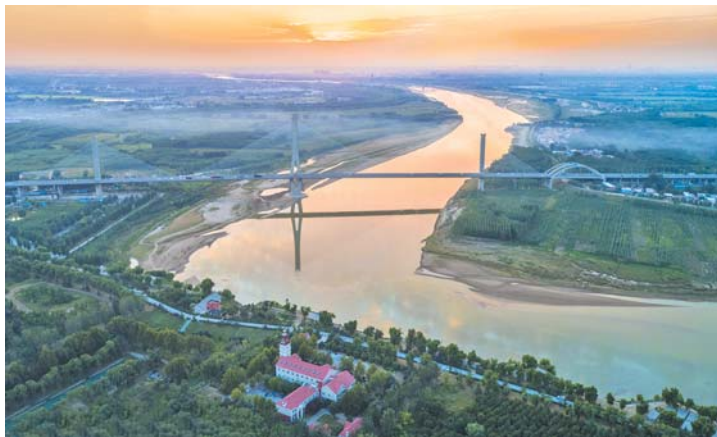
建邦黄河大桥联通南北,助力天桥黄河流域生态保护和高质量发展。
