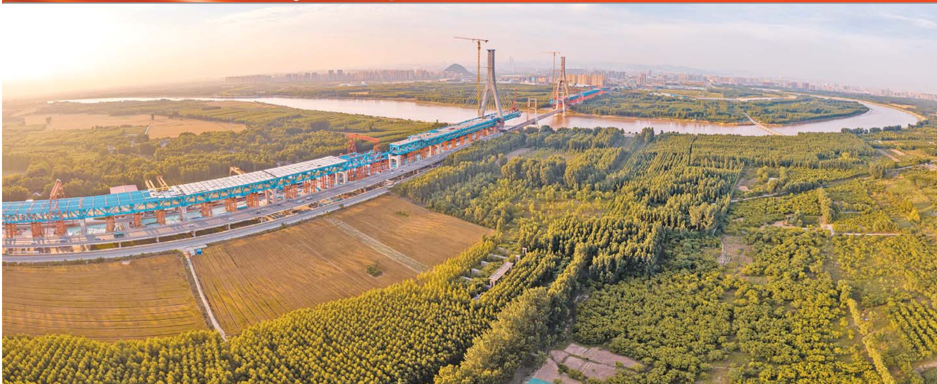
济南黄河公路大桥工程建设现场
