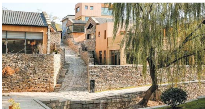
按照“三生三美”的要求,彩石街道积极开展齐鲁样板村建设,以齐鲁样板村建设助推乡村振兴。
