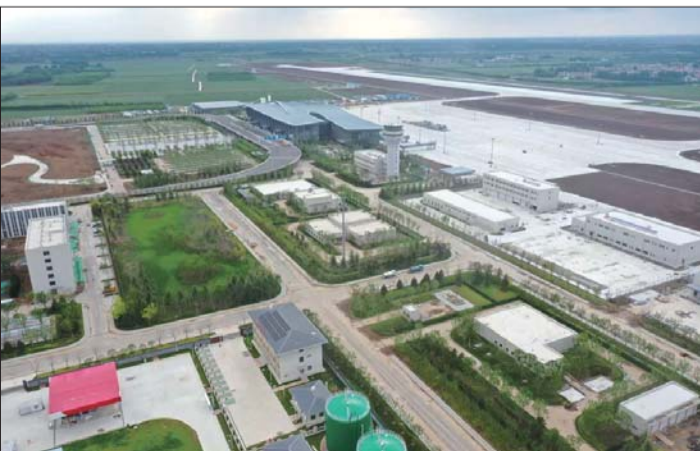
济宁城投承建的新机场项目。
