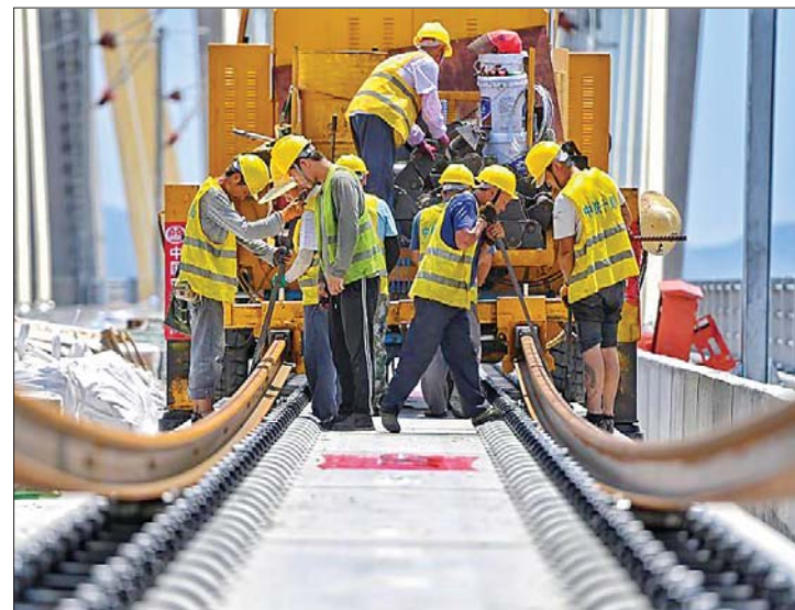
济郑高铁济南西站最后一组500米长钢轨顺利铺设到位。
