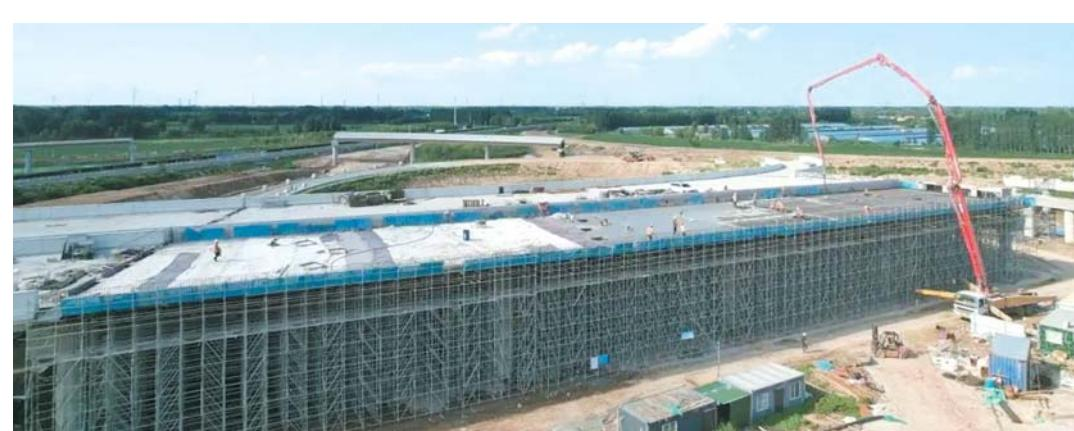
本报7月25日讯（通讯员 张磊）18日，随着最后一方混凝土成功入模，济南大北环项目二标段，稍门枢纽互通主线桥左幅第二联现浇箱梁施工完成（右图），标志着二标段在全线率先完成现浇箱梁施工，为后续桥面施工奠定了基础。
