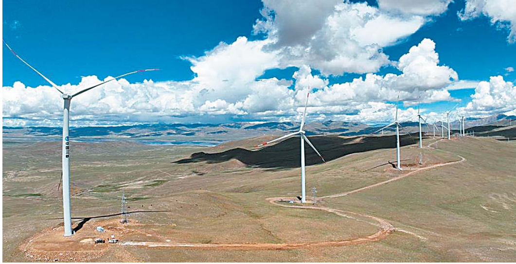
西藏措美哲古风电场 三峡集团供图
