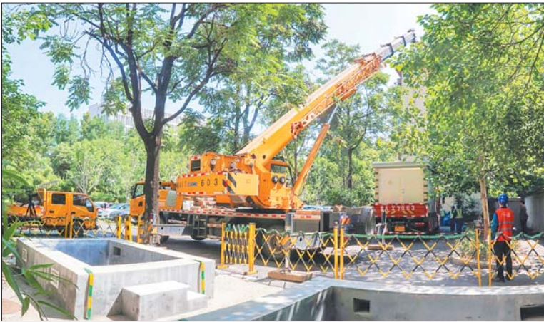
施工人员正在老旧小区供电户表改造现场吊装新的变压器。 何延海 摄
