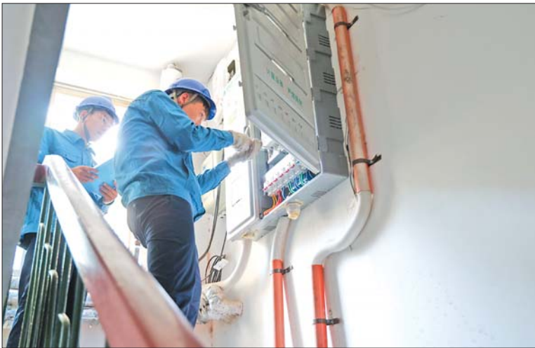
济南供电公司员工正在老旧小区供电户表改造现场安装新的智能电表。何延海 摄
