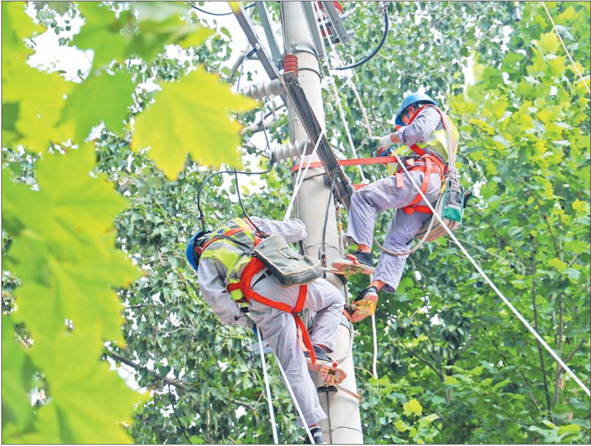
施工人员正在老旧小区供电户表改造现场升级改造供电线路。 何延海 摄
