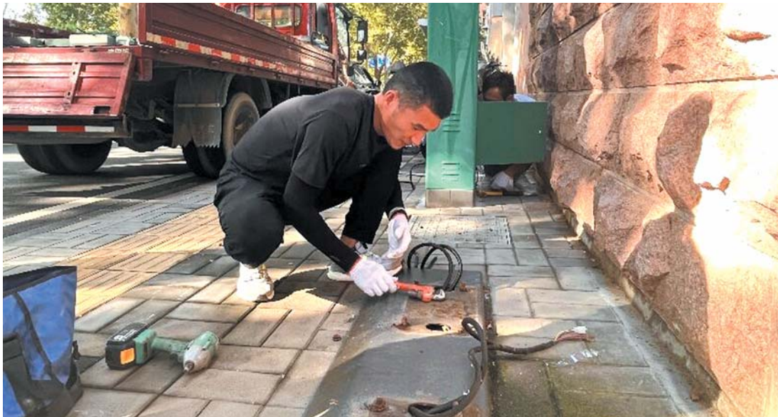
荒废六年的公共自行车停车点拆了。
