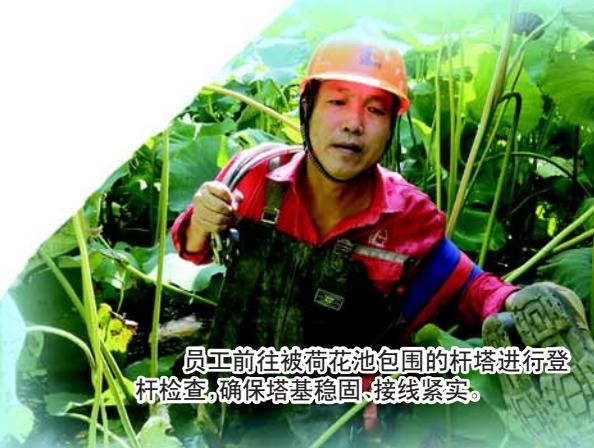
员工前往被荷花池包围的杆塔进行登杆检查,确保塔基稳固、接线紧实。
