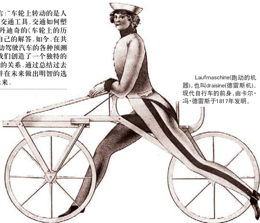
Laufmaschine(跑动的机器)，也叫draisine(德雷斯机)，现代自行车的前身，由卡尔·冯·德雷斯于1817年发明。
