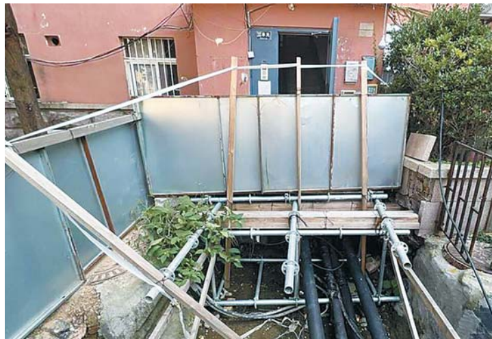
施工基坑给居民生活带来很大困扰。
