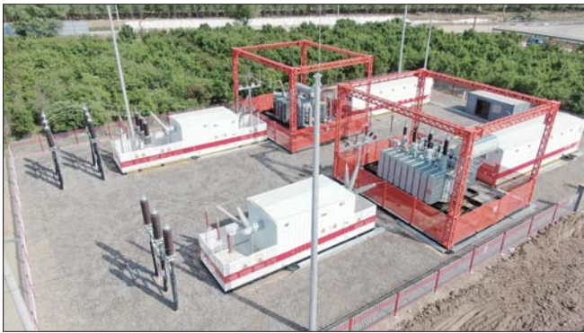
牛页一区“双机组”作业的电驱压裂变。 通讯员 谭蕾 摄
