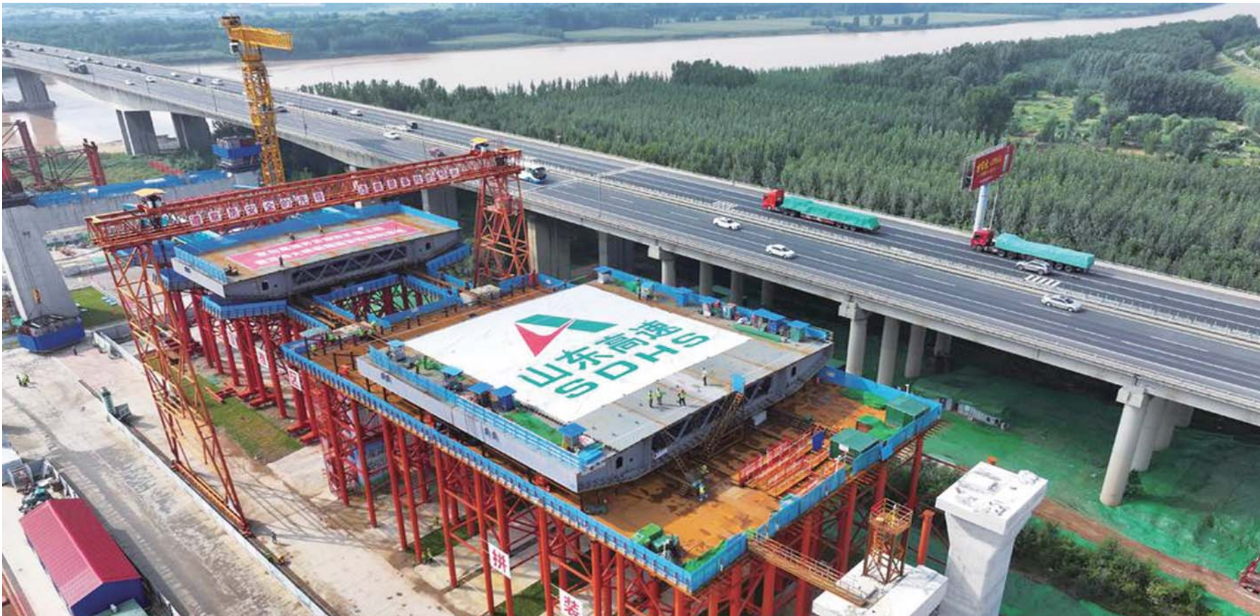
京台高速公路齐河至济南段改扩建重点控制工程黄河特大桥主桥首节段钢箱梁完成顶推作业。
