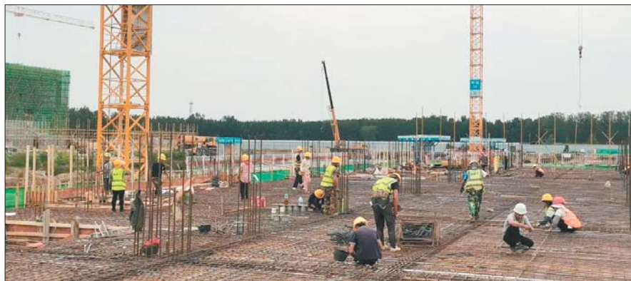
产发健康医药产业谷(加速器)施工现场
