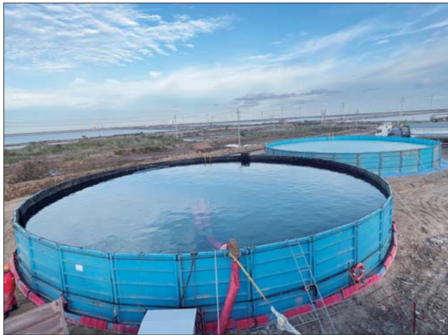
供水分公司仅用3天就建成两个高2.5米、直径约20米、储量各1000立方米的软体罐,确保开发单位重点井压裂压驱用水。 通讯员 宋卫东 摄
